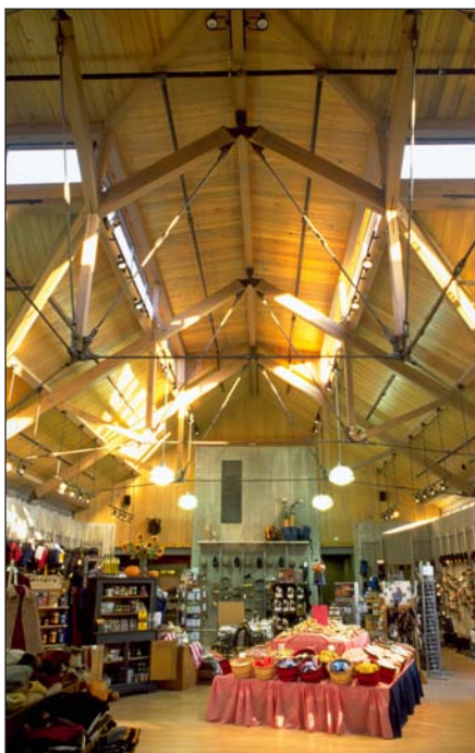
Bild 2: Blick auf die freitragende Dachkonstruktion aus Holz
